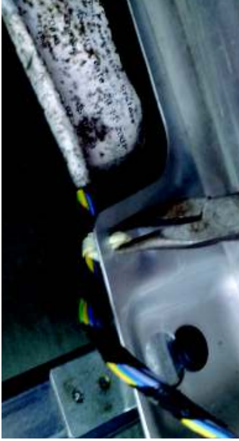
Entfernen des alten kabelbaums und dessen Kabelclips
